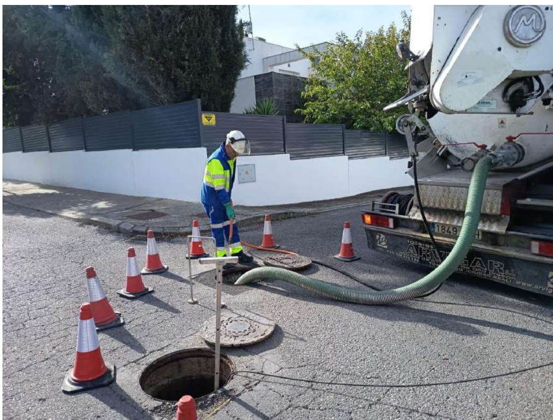
Operarios de Aqualia trabajan en la inspección de la red de saneamientos del Puente Tablas.
