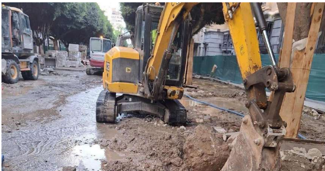
Interrupción de suministro de agua
